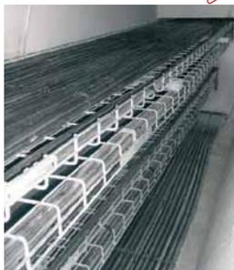
Lors de l'installation des câbles, les risques d'endommagement sont multiples : déchirure des gaines sur des obstacles coupants, cassure des câbles avec des angles aigus, etc...
