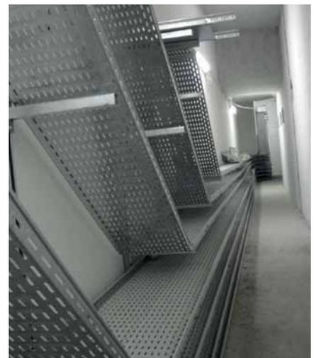
Le transport de courant dans les câbles induit un échauffement naturel des câbles. Cet échauffement ou dégagement de la chaleur que l'on mesure en joule est une conséquence normale de la résistivité du conducteur. Ainsi, la chaleur dégagée dans un espace fermé accroît la température ambiante, et par voie de conséquence la résistivité. Il requiert plus d'énergie pour le transport du courant.
