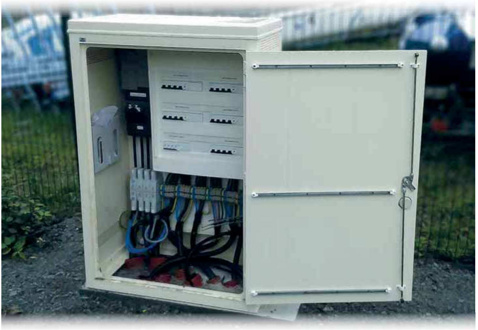
Armoire de protection et commande d'éclairage d'un camping dans Les landes (Région Aquitaine)
